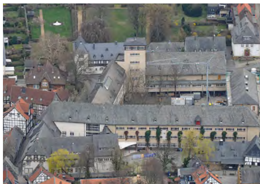
Kulturmarktplatz während der Bauarbeiten 2019 (Foto: Günter Piegsa)
