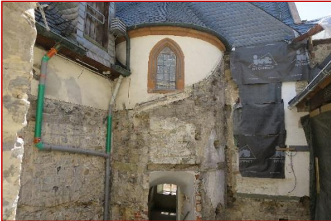
Baustelle Rathaus: Blick in den Innenhof. (Foto: Dr. Bauer)
