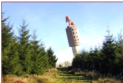
Sprengung Schalker Turm am 11.10.2002 13:00 h. Mit 763 m üNN ist die Schalke die höchste Erhebung der Goslarer Stadforst. (Foto: Martin Schenk)
