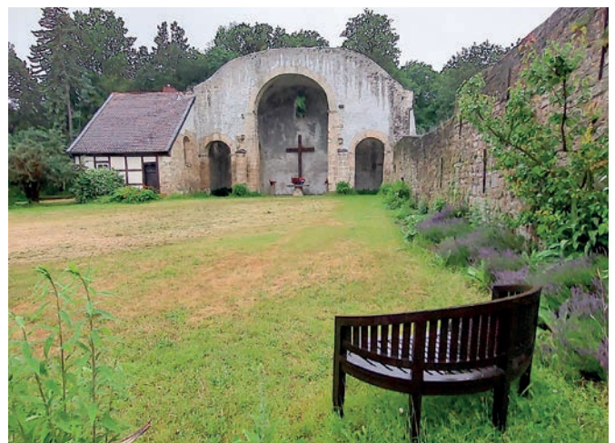
Reste des Westriegels, gesehen aus Richtung Chor (von Osten)
